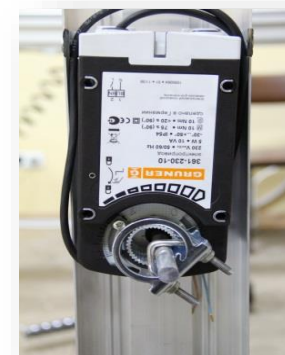
Клапан КВА с электроприводом Gruner
